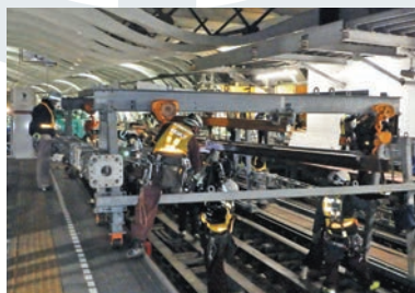
銀座線渋谷駅切替工事の様子
