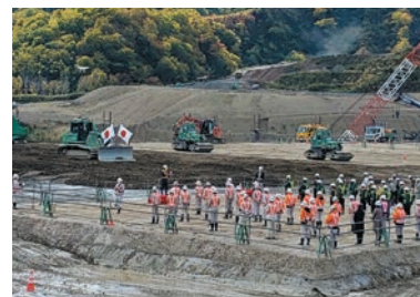
成瀬ダム 100万㎡突破完了記念の様子
